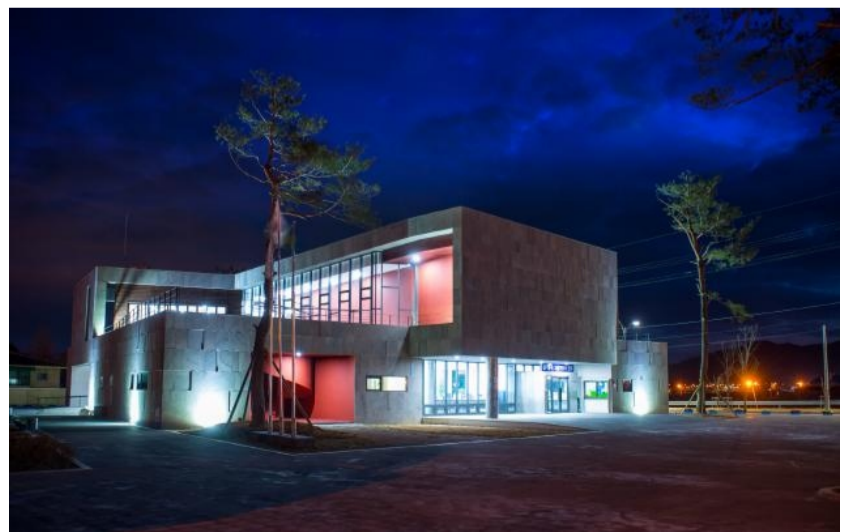
2013 제8회 한국농촌건축대전 준공건축부문 대상 영주 풍기읍사무소_ 최재원 건축사/(주)디자인그룹오즈 건축사사무소
