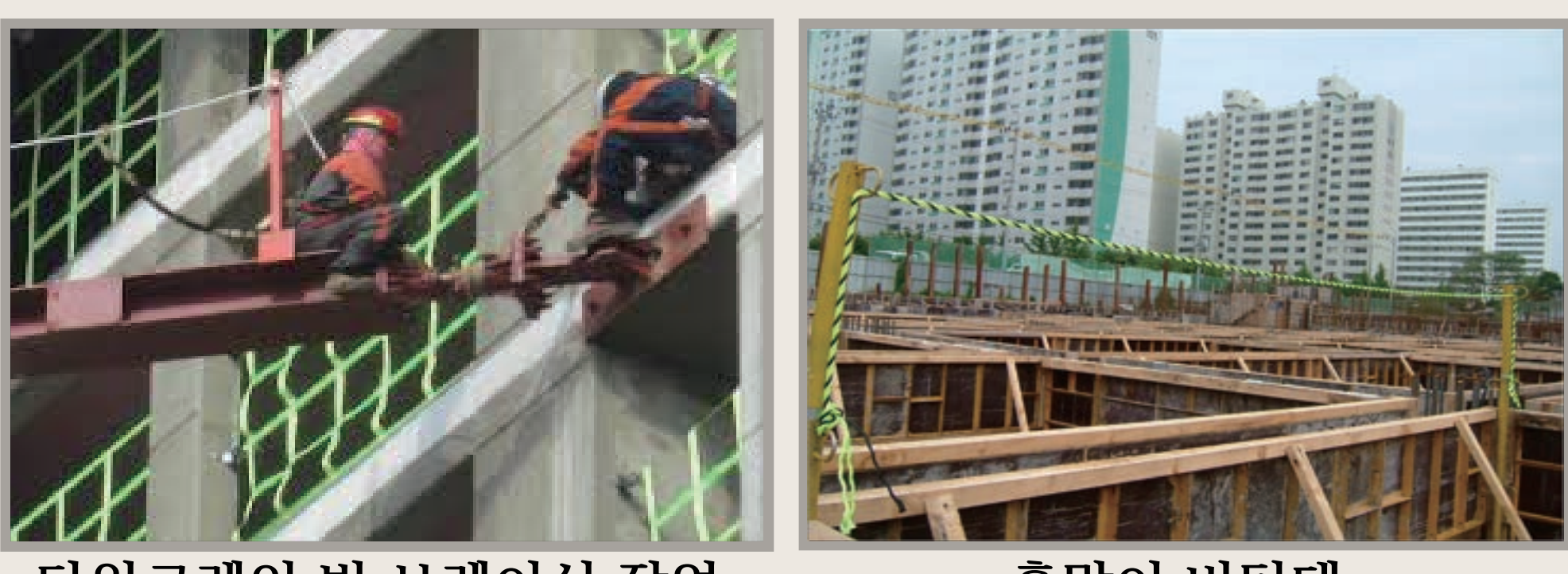
타워크레인 빔 브레이싱 작업
