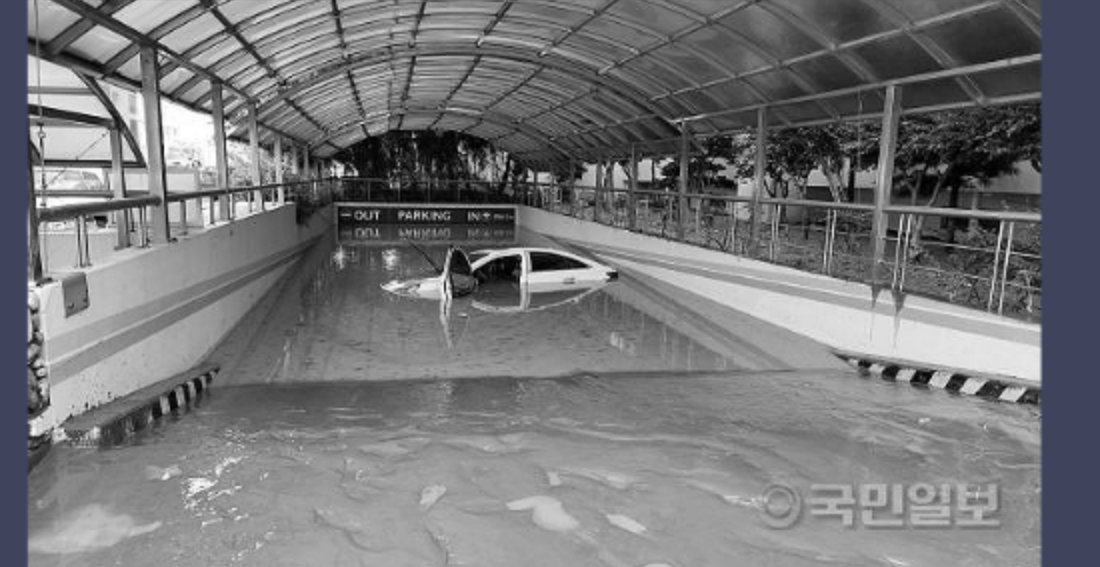
2022.9 포항 지하주차장 침수
