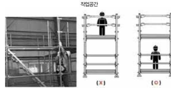
본 설계안은 작업자는 하부에서 상부의 안전 난간을 설치할 수 있어 설치 중의 추락 위험을 감소할 수 있는 강관 비계 선행 안전난간 방식을 제안하고자 한다.
