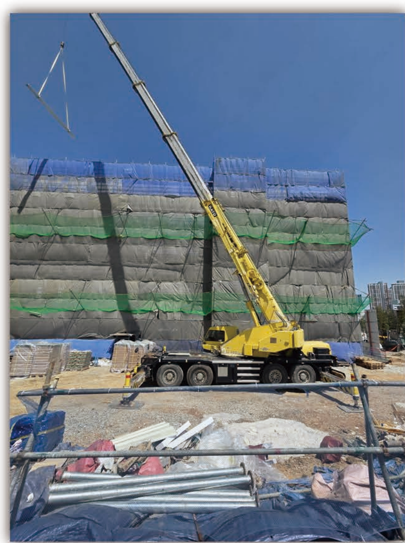
<군산시 조준동 행정복지센터 신정사 공사현장>
